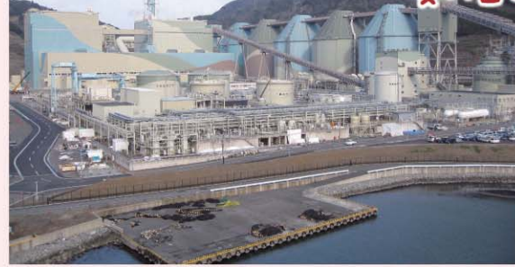
舞鶴火力発電所
